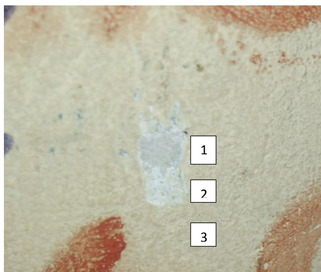
Fot. Odkrywki nr 1 – 1. cementowy odlew, 2- biała warstwa malarska, 3 – obecna warstwa malarska
