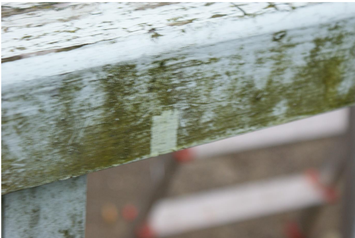
10. Widok na zagłonięcie balustrady
