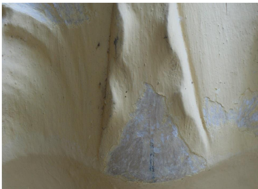
Fot. odkrywki nr 5 - widoczny oryginalny kolor kremowobiały.
