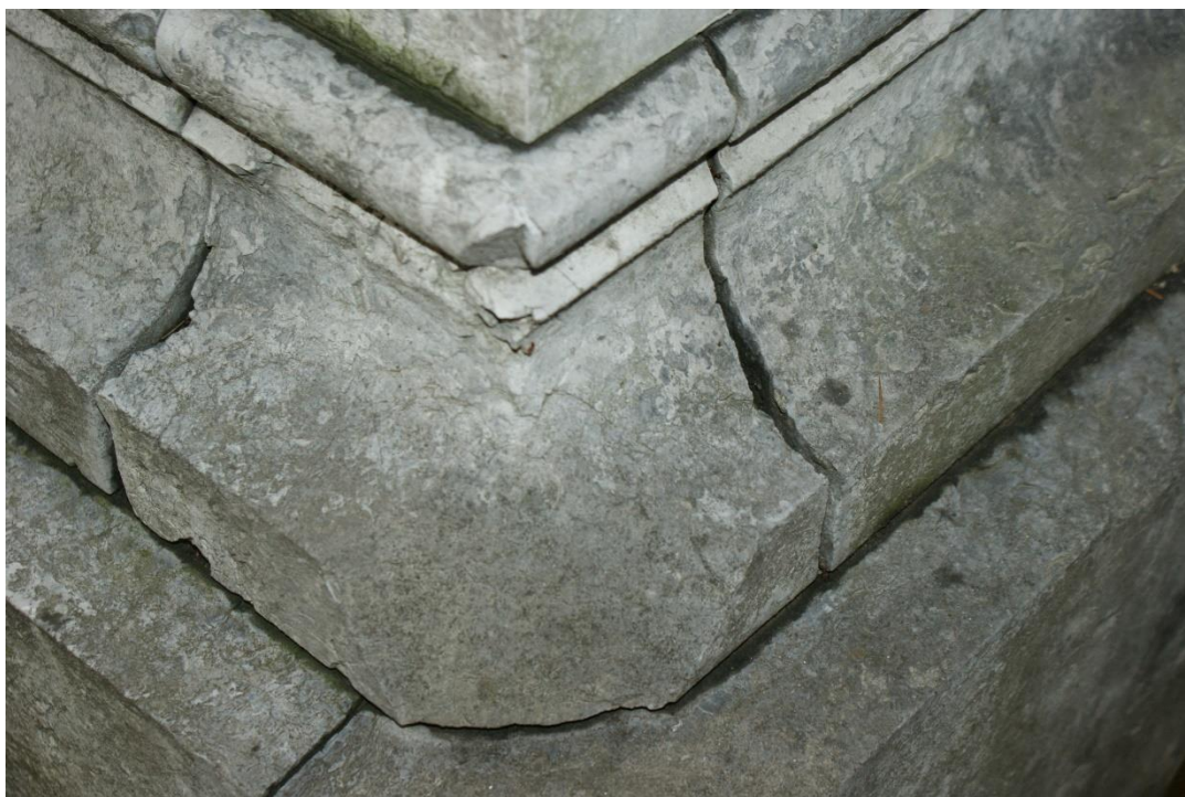
7. Zniszczenia podstawy postumentu
